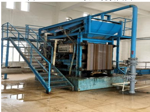
图 2.3.2-16 污泥脱水机房现状图
