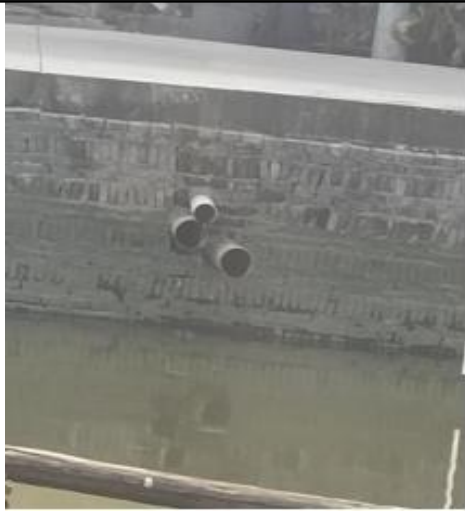
鸡头口涌排口
