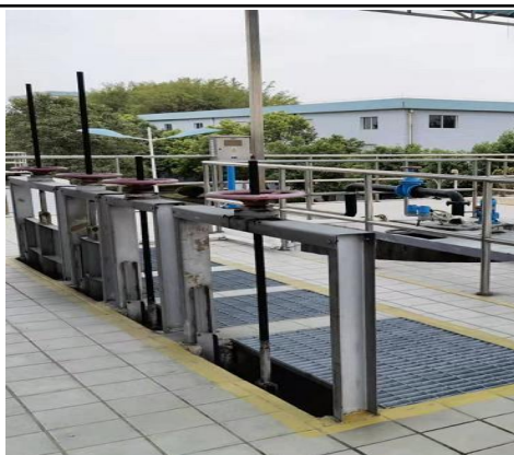
图 2.3.2-4 细格栅池、旋流沉砂池
