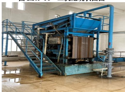
图 2.3.1-18 污泥脱水机房现状图
